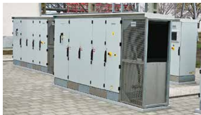
Obr. 2 Nové batériové úložisko predstavuje kľúčový technologický prvok, ktorý podniku umožňuje nielen optimalizovať vlastnú spotrebu, ale aktívne sa podieľať na primárnej regulácii vonkajšej nadradenej siete.
